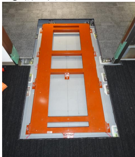
② 調整架台取付
